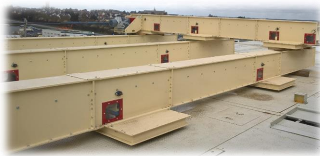
Transporteur à chaîne avec vannes sous transporteur :
